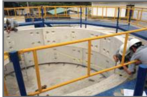
LẮP ĐẶT THỬ CÁC RING Ring Installation Test.
