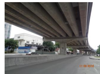
Hình 3: Dầm U Cầu vượt tại Malaysia
