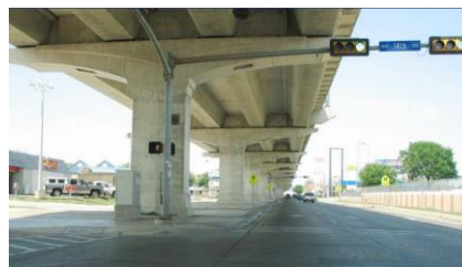
Hình 2: Dầm U – cầu cạn Austin Bergstrom, Mỹ
