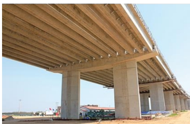
Hình 1: Dầm Super T cầu Nhật Tân, Việt Nam
